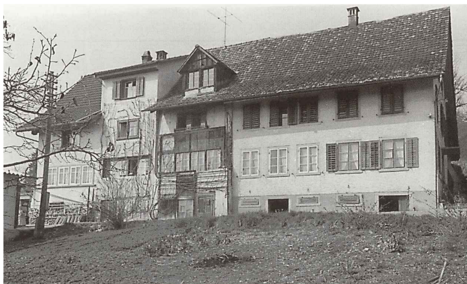
Haus Nummern 9, 11, 13 und 15 im Jahr 1963 Ursprüngliche Fassade nur noch in der Mitte (13).
